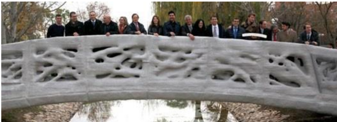
7. ábra: Madridban telepített 3D-nyomtatott gyalogshíd. 56-ról
