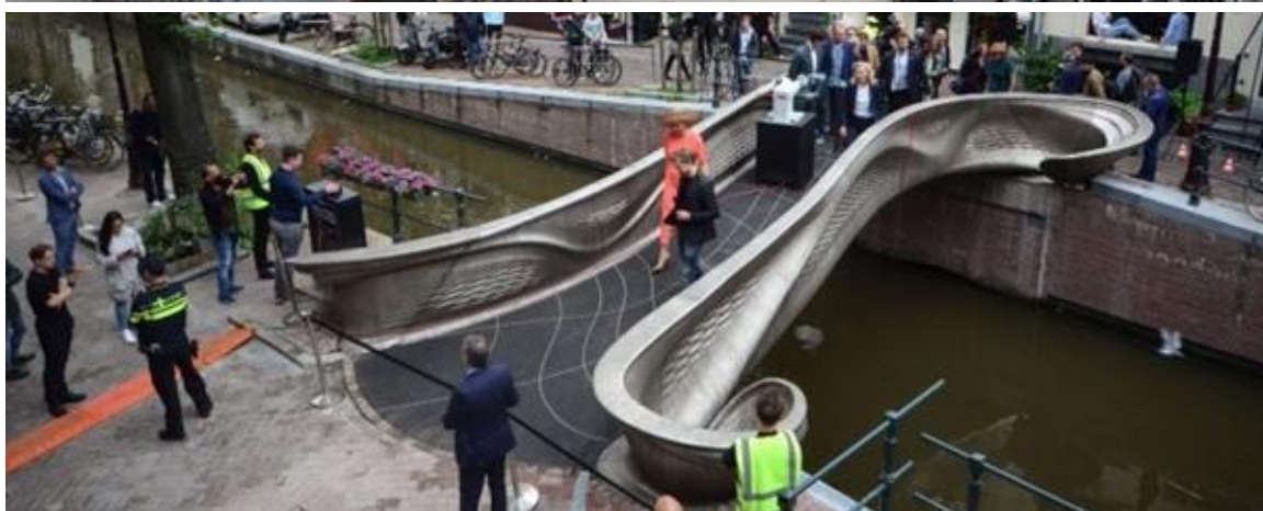
13. ábra. A világ első 3D-nyomtatott jemiája Joris Laarmantól, MX3D és AKUP Amsterdamban. 70
